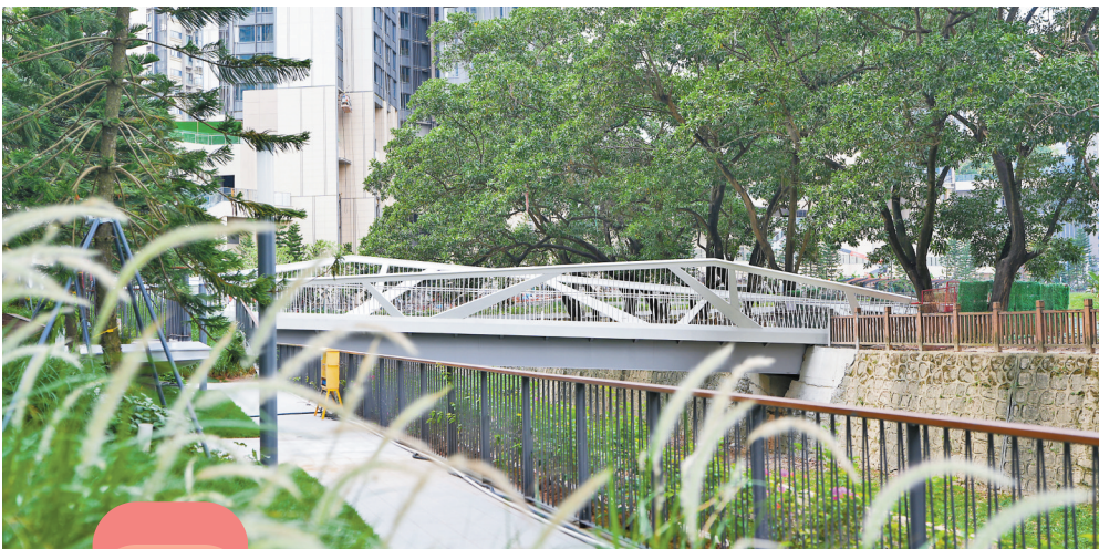
高峰明渠沿岸打造了丰富的景观。龙华新闻记者 蔡维泽 摄
