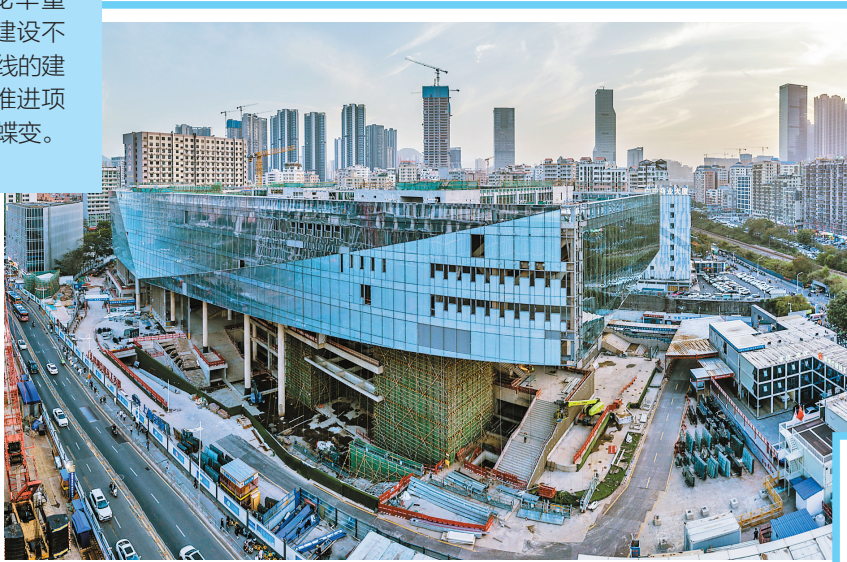
深圳市文化馆新馆总体形象进度已完成77%。
