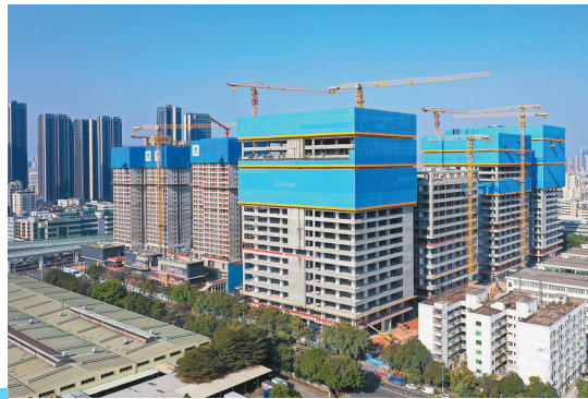
建设中的建泰城市更新项目(龙华超级商圈)。
