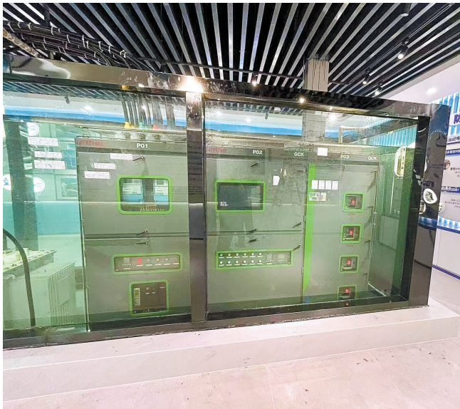
放置于水池中的是南方电网首套防水浸中低压配电设备。
