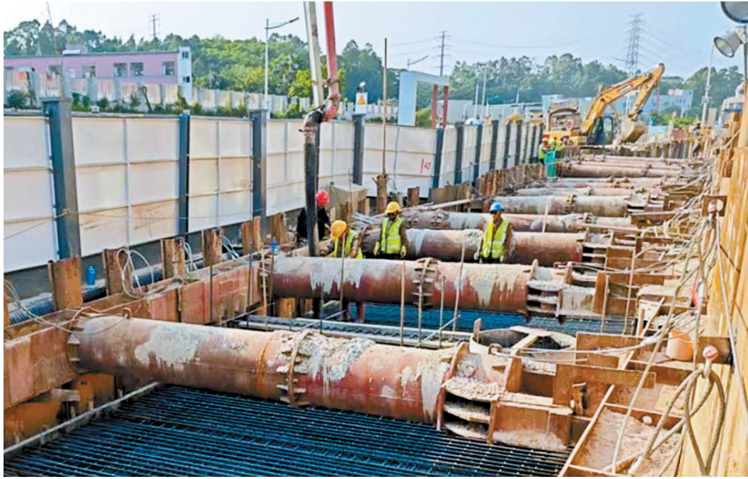
泗黎路库坑段雨水箱涵工程施工现场。
