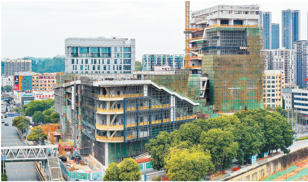
观湖文体中心主体结构全面封顶。
