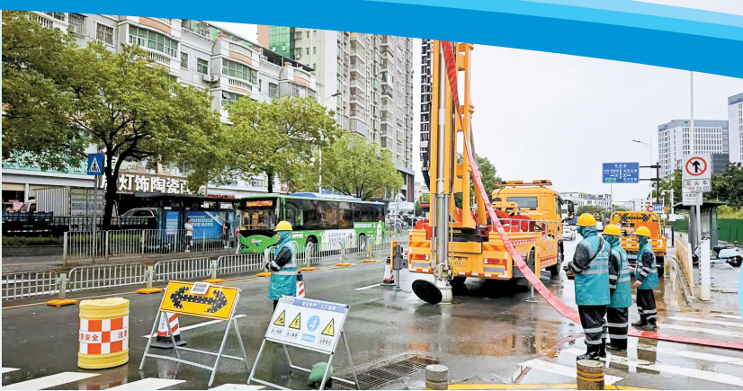
龙华排水公司做好应急和排水保障工作。
